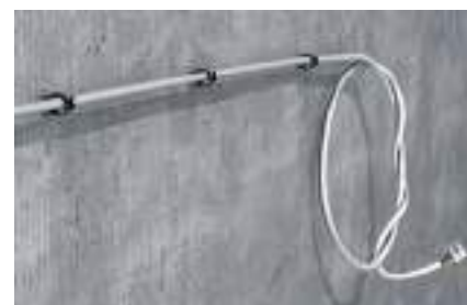
Mocowanie rurek za pomocą opaski i kołka do opasek
