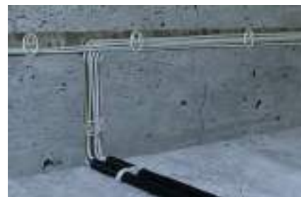
Mocowanie kabli w szczelinach < 55 mm
