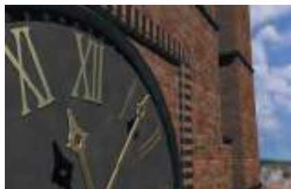
Renowacja ścian osłonowych
