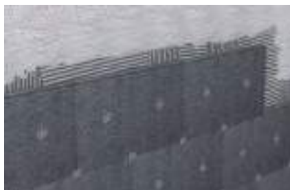
Dodatkowe wzmocnienie ścian ETICS
