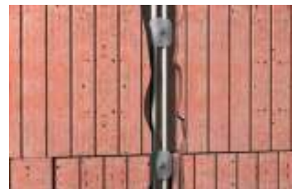
Mocowanie kabli w szczelinach
