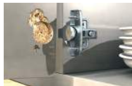
Naprawa zniszczonych zawiasów
