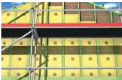
Mocowanie płyt izolacyjnych w fasadach wentylowanych
