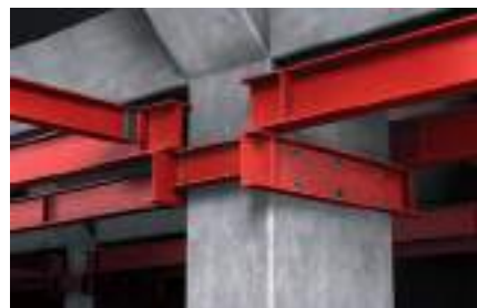
Mocowanie dźwigarów stalowych
