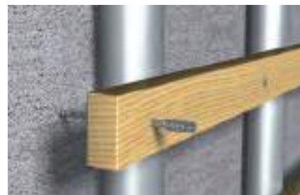
Montaż z odstępem
