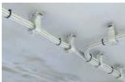
Związywanie kabli elektrycznych
