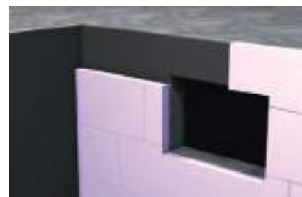
Uszczelnianie ościeżnic okiennych i futryn
