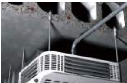
Urządzenia klimatyzacyjne mocowane do płyt kanałowych
