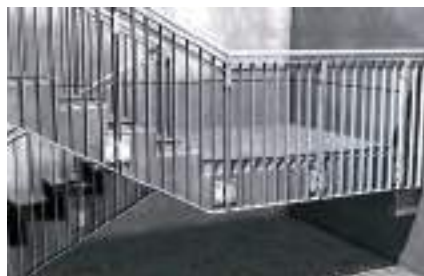
Czołowe mocowanie balustrady
