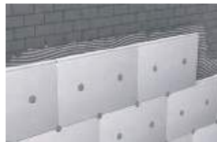
Sztywne płyty styropianowe O35 na bloczkach silikatowych
