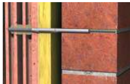
Detail: renowacja ścian osłonowych
