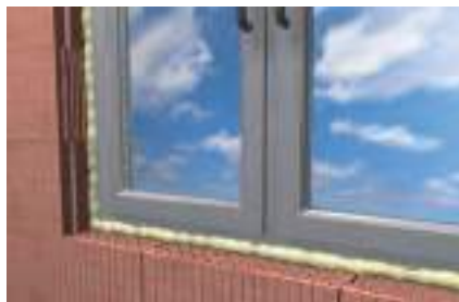
Uszczelnianie ościeżnic okiennych i futryn
