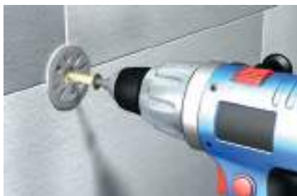
Wkręcanie kołków do płyt izolacyjnych
