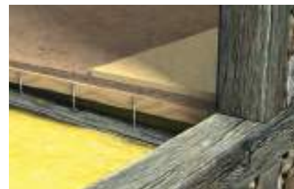
Montaż z odstępem
