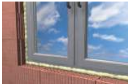
Uszczelnianie ościeżnic okiennych i futryn
