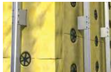
Termoizolacja w fasadzie wentylowanej
