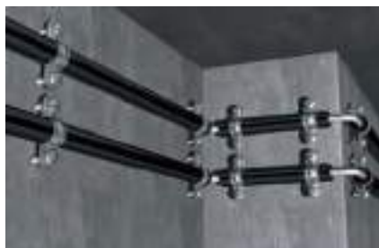
Mocowanie przewodów stalowych
