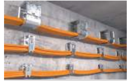
Mocowanie kabli do ściany
