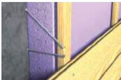
Montaż z odstępem
