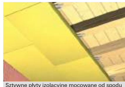
Sztywne płyty izolacyjne mocowane od spodu stropu
