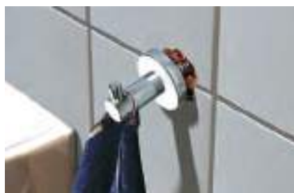
Naprawa uszkodzonych otworów
