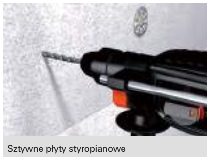
Wbijanie kołków na sztywnych płytach styropianowych
