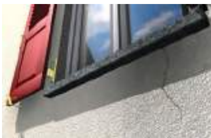
Uszczelnianie rys i pęknięć
