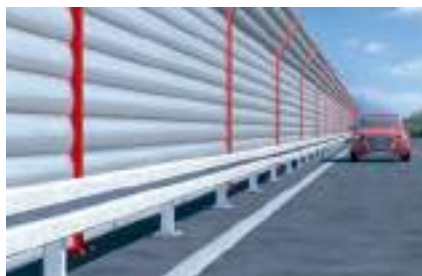
Bariery drogowe i ekrany akustyczne
