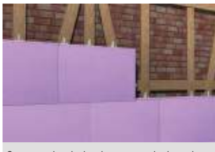
Sztywne płyty izolacyjne na ruszcie drewnianym
