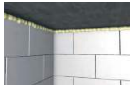
Uszczelnianie złączy liniowych
