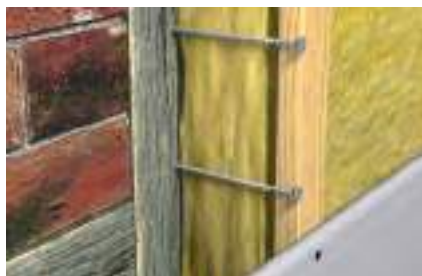
Montaż z odstępem
