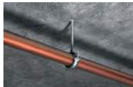
Podwieszenie rurociągu
