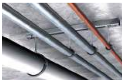
Podwieszenie lekkich rurociągów
