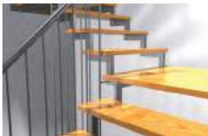
Mocowanie stopnic na schodach metalowych
