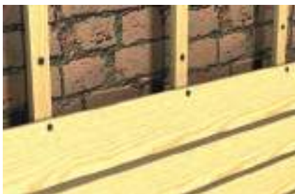
Montaż z odstępem
