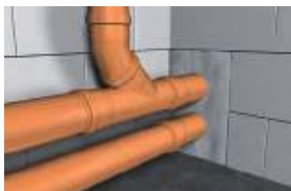
Wypełnianie prześwitów i bruzd dla rur
